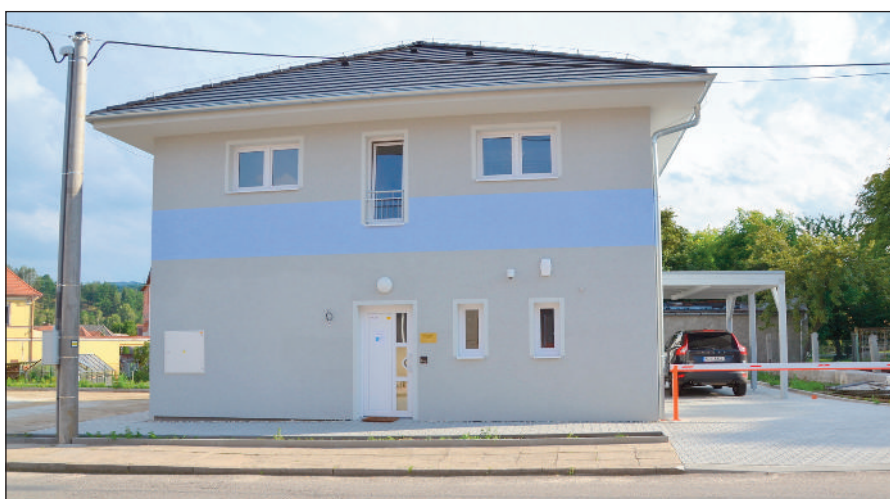
Budova nové ordinace MUDr. Křížové
