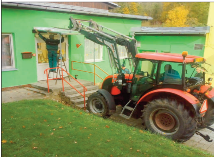
Montáž přístřešku nad vchodem do spojovacího pavilonu (J. Tomášek, M. Bastl)
